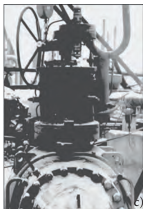
Figura 6. Turbomotor precesional reactiv pentru armatura magistrelor de gaz: desen tehnic (a); vederea 3D (b); turbomotor precesional agregatizat cu conducta de magistrală (c)
