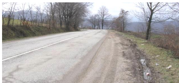
Aliniament cu curbă orizontală de rază mică spre stânga după deal
