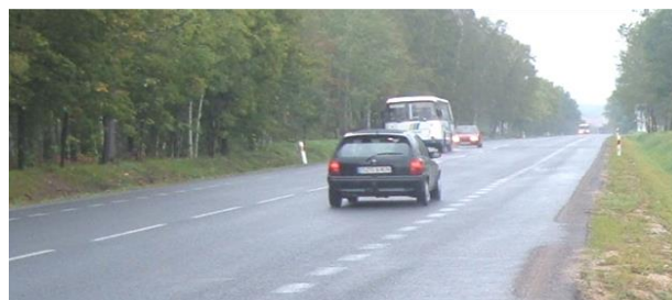
Drum 1+1 cu acostament rigid (asfaltat) supralărgit
