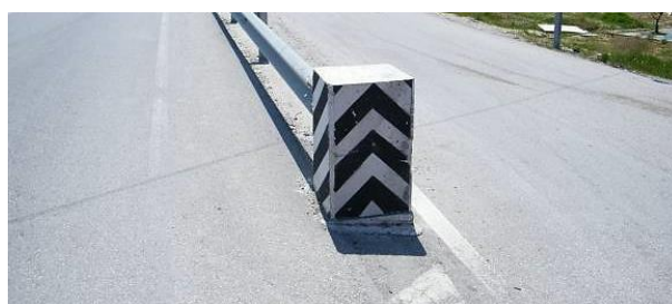
Extremitate periculoasă cu bloc de beton
