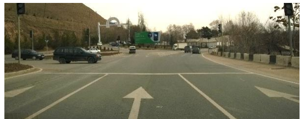
Lipsa de canalizare în intersecție
