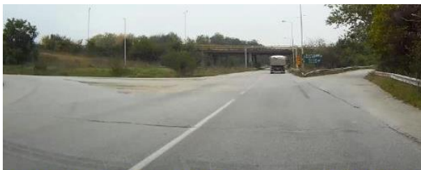
Lipsa de canalizare în intersecție
