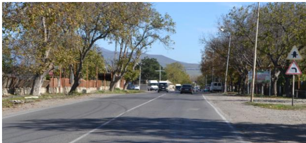
Curbă strânsă stânga + iluzie optică (drumul secundar în curbă se percepe ca drum pe direcția înainte)
