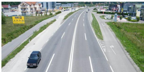
Drum cu profil transversal 2+2 cu mixt de funcții
