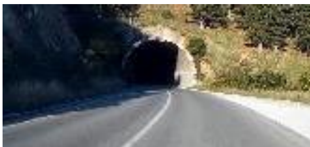
Lipsă de iluminare în tunel
