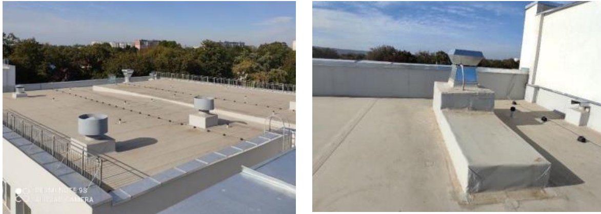
Figura 5. Vedere acoperiș al clădirii
