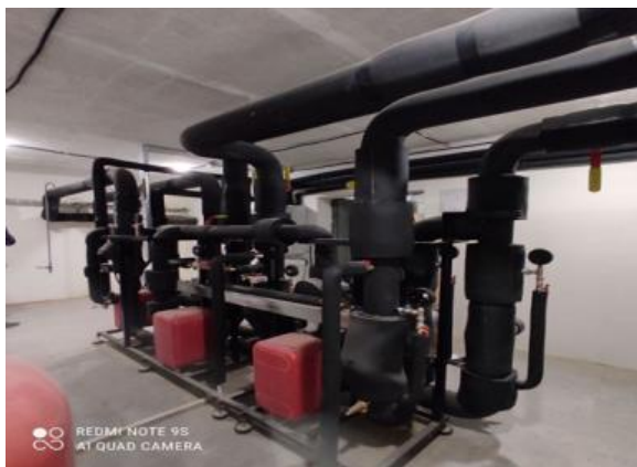
Figura 14. Vedere a punctului termic individual
