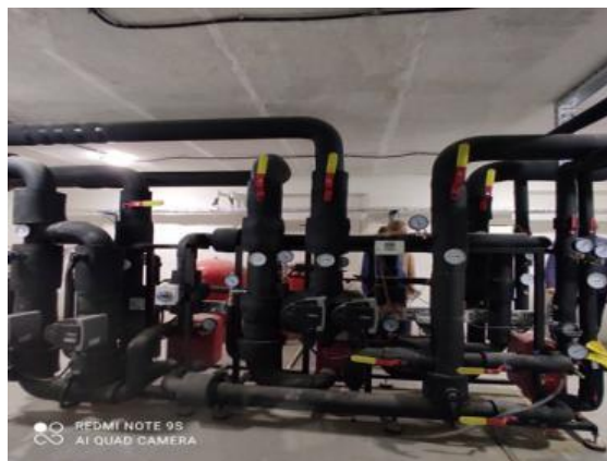
Figura 14. Vedere a punctului termic individual
