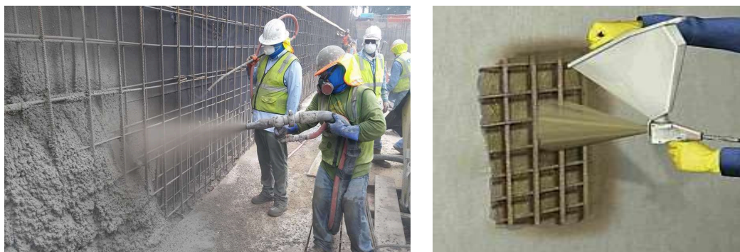
Figura 2. Turnarea betonului torcretat [2]
