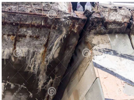
Figura 1. Coroziunea chimică a betonului [1]
