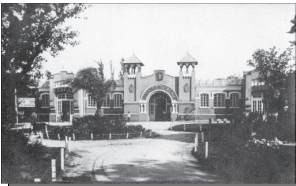
Pavilionul Industriei metalurgice
