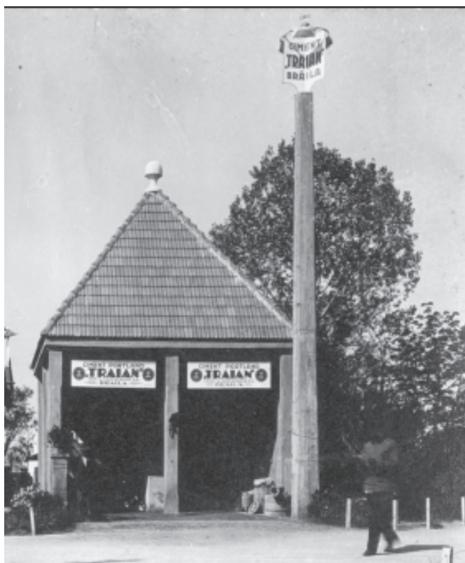
Pavilionul fabricii de ciment "Traian"
