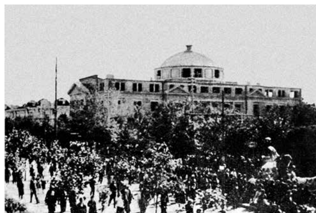
Foto 11. Clădirea Palatului Culturii în proces de construcție, 1937.
